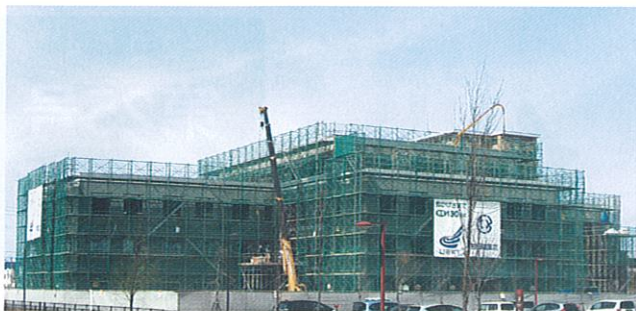
建設工事が進む鏡町の特別養護老人ホーム
