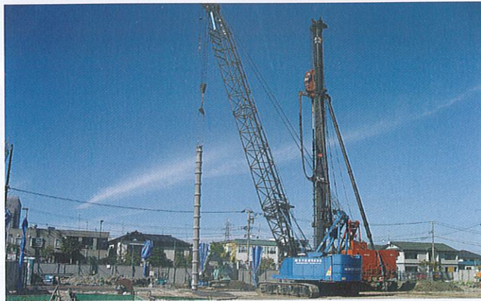
大型重機による杭打設工事
